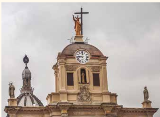
FACHADA DE LA IGLESIA DEL VOTO NACIONAL LUEGO DE LOS TRABAJOS DE RESTAURACIÓN POR PARTE DEL INSTITUTO DISTRITAL DE PATRIMONIO CULTURAL. FOTOGRAFÍA: INSTITUTO DISTRITAL DE PATRIMONIO CULTURAL-IDPC
