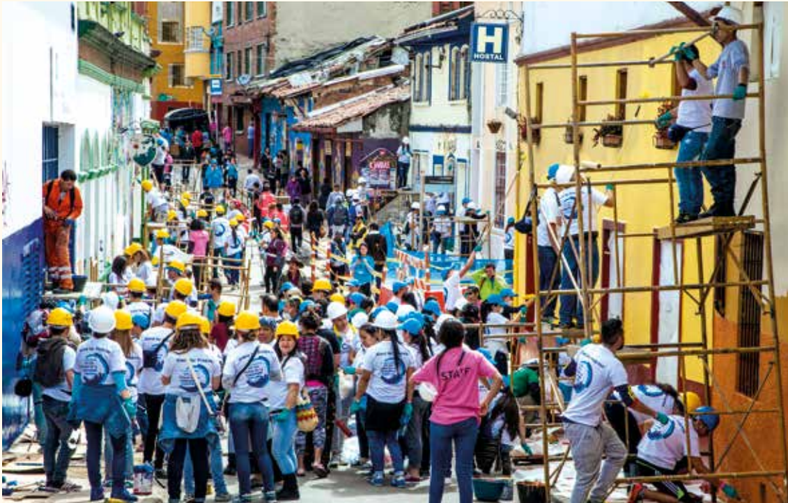
JORNADAS DE ENLUCIMIENTO DE FACHADAS. FOTOGRAFÍA: INSTITUTO DISTRICTAL DE PATRIMONIO CULTURAL (IDPC)
