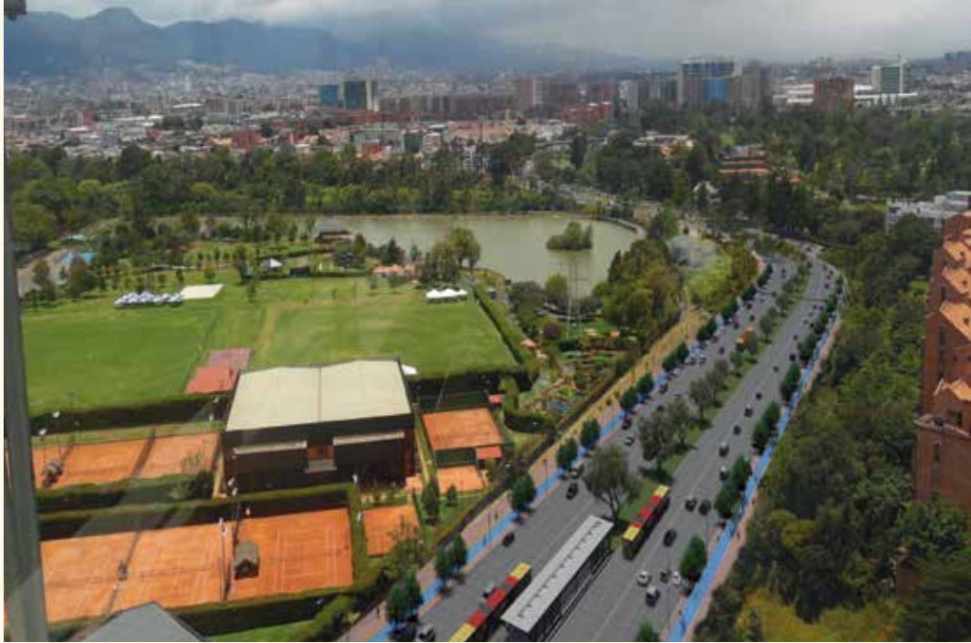
TRONCAL DE LA AVENIDA BOYACÁ. IMAGEN: INSTITUTO DE DESARROLLO URBANO (IDU)
