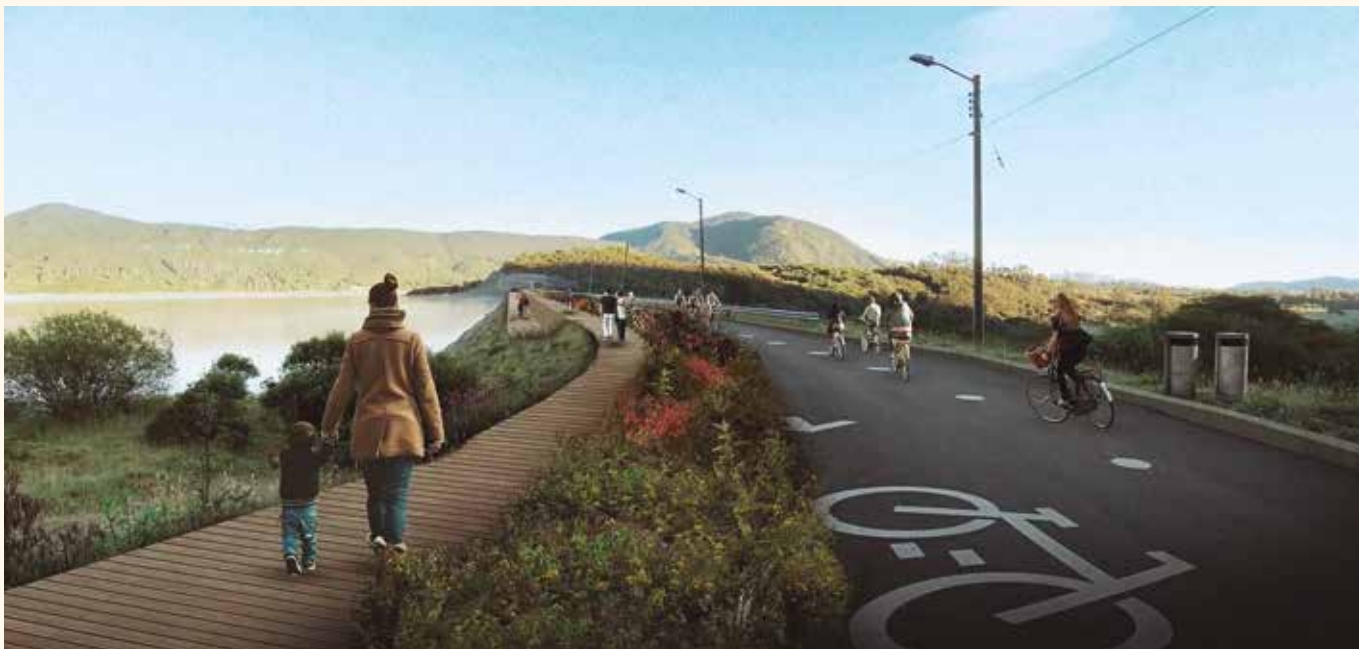
EMBALSE DE SAN RAFAEL. IMAGEN: EMPRESA DE ACUEDUCTO Y ALCANTARILLADO DE BOGOTÁ
