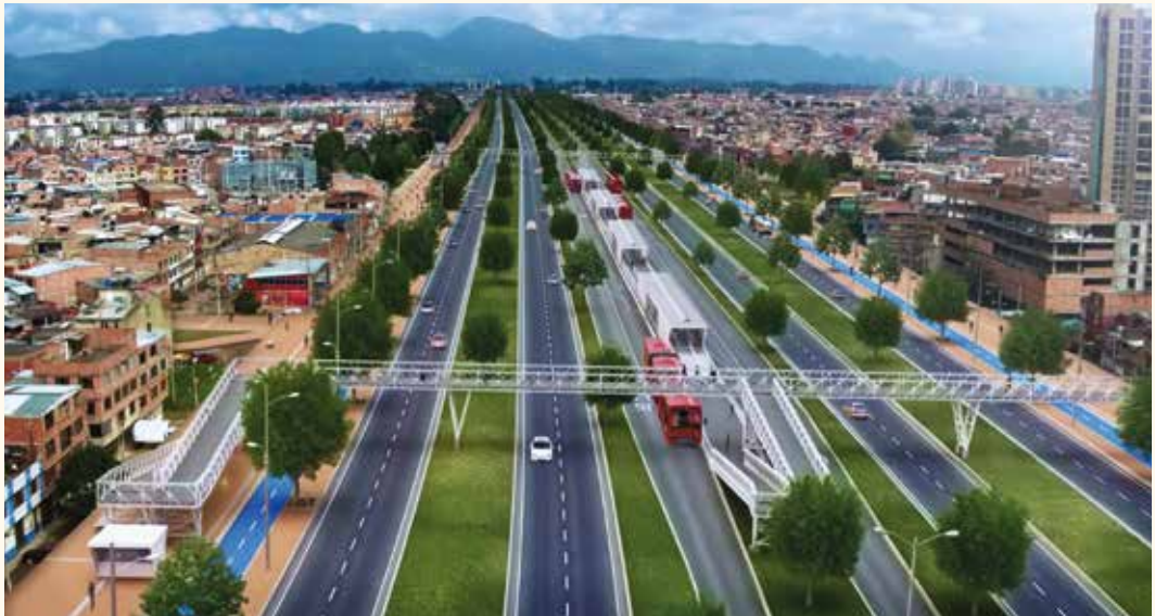
AVENIDA LONGITUDINAL DE OCCIDENTE. IMAGEN: INSTITUTO DE DESARROLLO URBANO (IDU)
